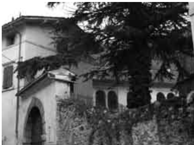
La facciata di una dimora storica a Peri.
