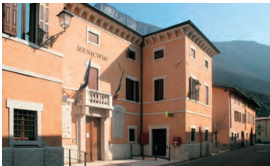
La storica facciata del Municipio di Dolcè.
