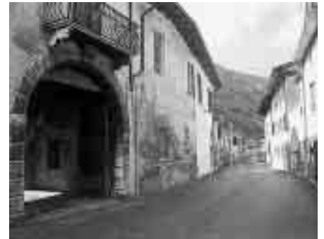
Corti che si aprono sulla vecchia via Trentina a Dolcè.
