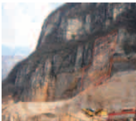
Nella foto, l'area della cava di Ossenigo interessata dalla frana.
