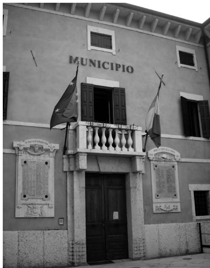
Uno scorcio della facciata d'ingresso del Municipio.
