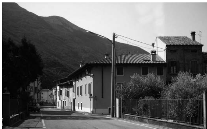
Dolcè, ingresso lungo via Trento a nord del paese.
