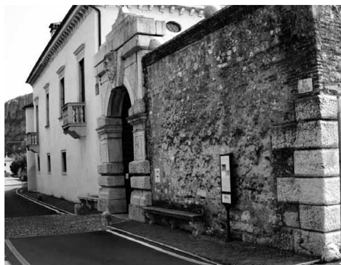
Volargne, scorcio della massiccia facciata e del portale di accesso a Villa Del Bene.
