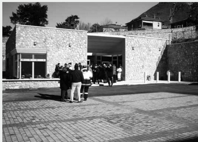
L'edificio Polifunzionale di Dolcè visto dall'esterno.
