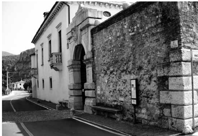
Volargne, scorcio della massiccia facciata e del portale di accesso a Villa Del Bene.
