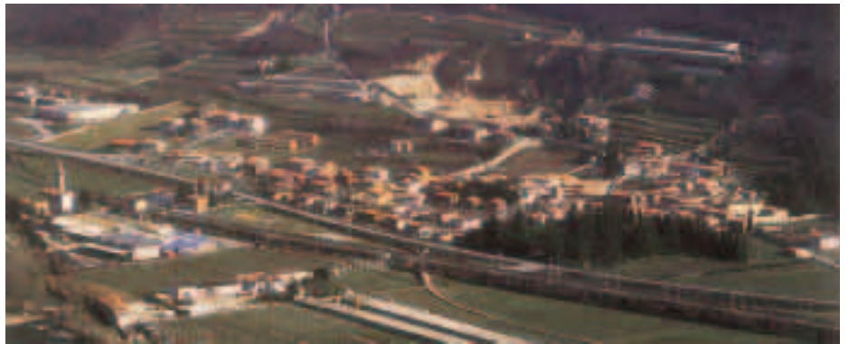
L'abitato di Dolcè visto da sud-ovest.
